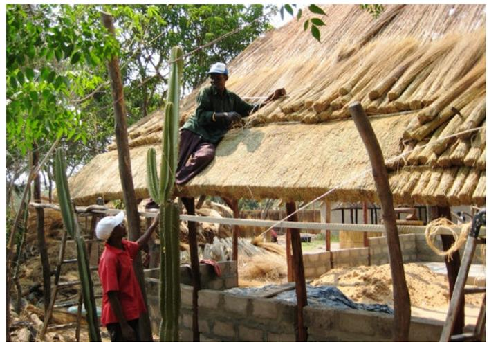
Beim Dachdecken werden zwei verschiedene Gräser verwendet: *Matenganya* zuerst, darüber *Mwange*
