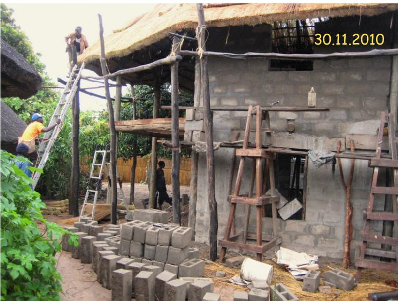
Viel Arbeit liegt noch vor uns, aber wir sind zuversichtlich, dass wir den Rohbau bis zur Weihnachtspause vollenden können, einschließlich Dach und Betonböden unten sowie Verlegen aller elektrischen Leitungen. Das obere Stockwerk bekommt Holzfußböden, die gleichzeitig als Decke für die unteren Räume dienen.
