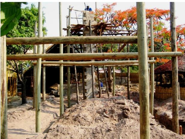
Im Vordergrund entsteht der zweite Gebäudeteil, der Schornstein wird acht Meter hoch; hinten: Speisesaal
