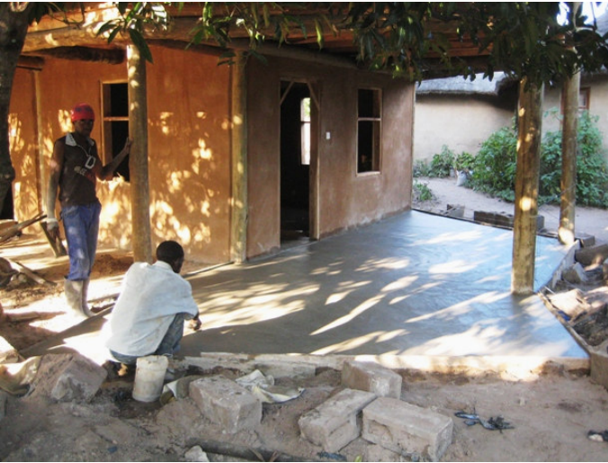
Der Betonboden vor dem Internetcafe ist gegossen (April 2011)
