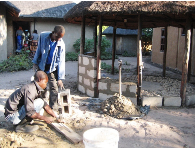
Zementblocks werden zwischen die Dachpfosten gemauert
